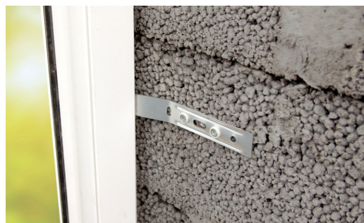
Крепление анкерной пластины
