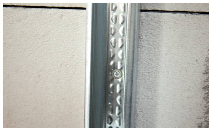
Крепление обрешетки гипсокартона
