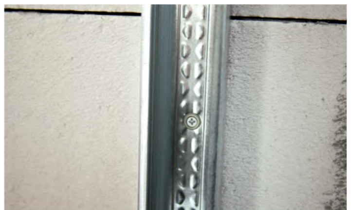
Крепление обрешетки гипсокартона
