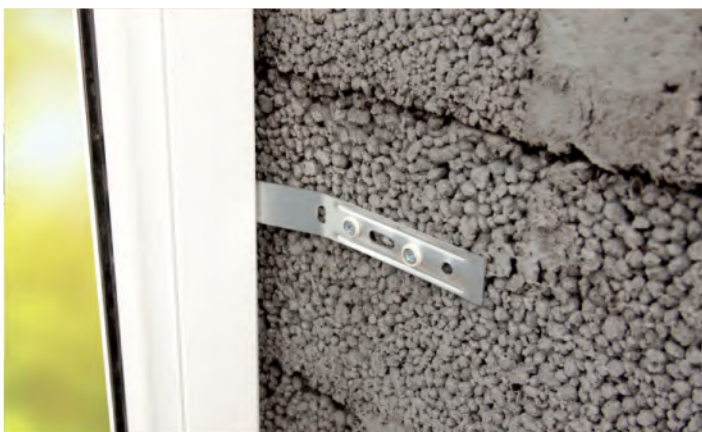
Крепление анкерной пластины
