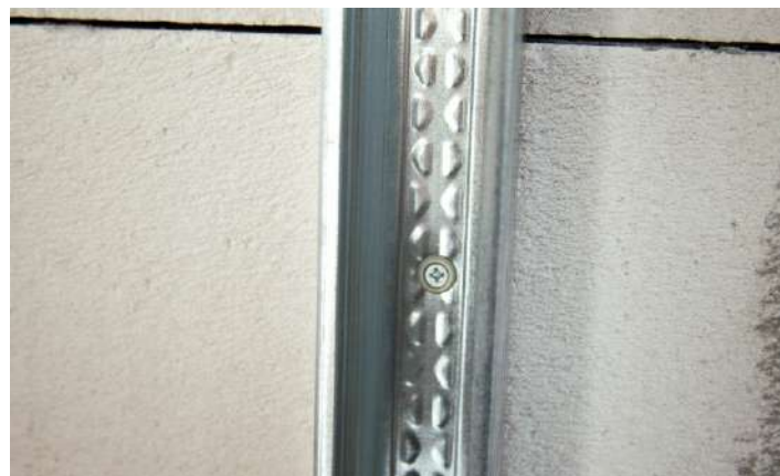
Крепление обрешетки гипсокартона
