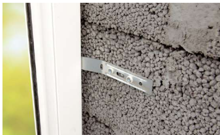
Крепление анкерной пластины
