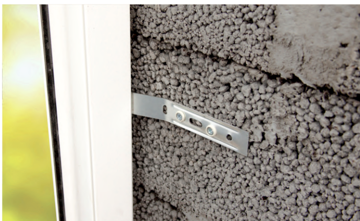
Крепление анкерной пластины
