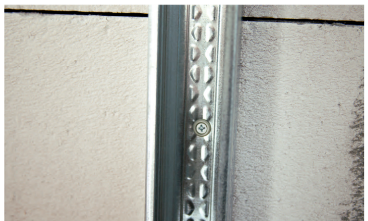
Крепление обрешетки гипсокартона
